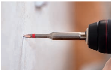
1. Loch in Steinzeugfliese bohren mit C PROTECTOR
